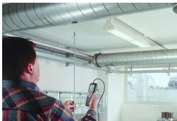
testo 425, используется, например, для настройки кухонных приточных вентиляционных каналов
